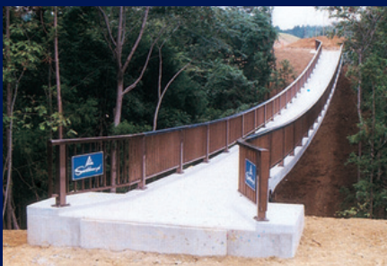
サザンヤードカントリークラブ 設計：鹿島建設株式会社 施工：鹿島建設株式会社 （新素材アラミド繊維使用の軽量コンクリート）
