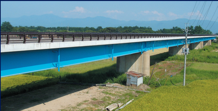
床版架替工（高強度軽量プレキャストPC床板）、大川橋 秋田県 施工：ピーシー橋梁共同企業体
