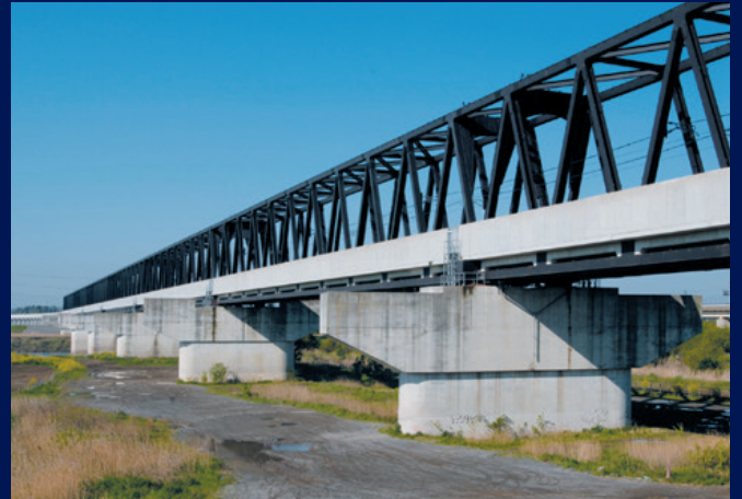
つくばエクスプレス・利根川橋梁（日本鉄道建設公団） 施工：IHI・NKK・松尾共同企業体 他
