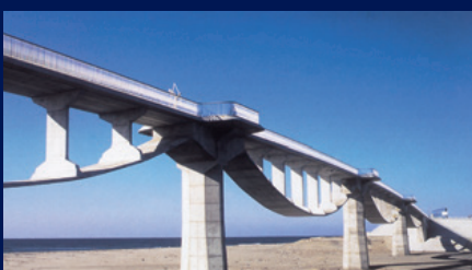
浜松御前崎自転車道 潮騒橋 施工：住友建設株式会社
