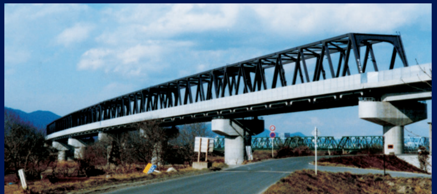
北陸新幹線、第三千曲川橋梁（日本鉄道建設公団） 施工：横河ブリッジ共同企業体
