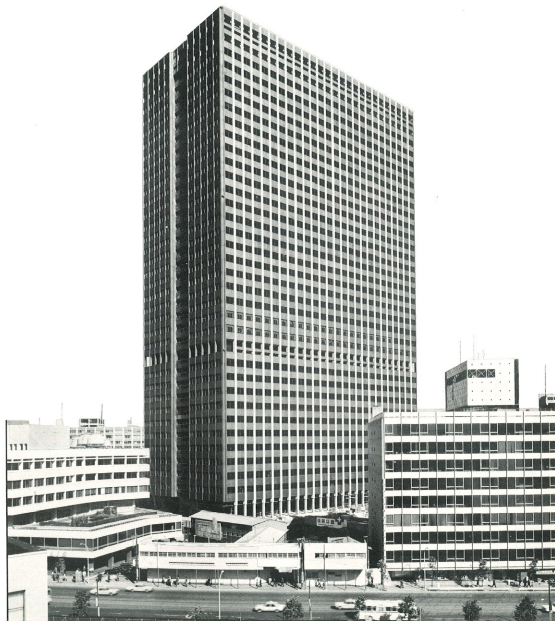
(最近のメサライト工事例) 霞ヶ関超高層ビル
