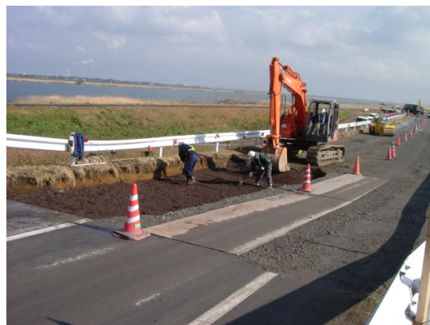
カルグリ敷均し状況(人力)
