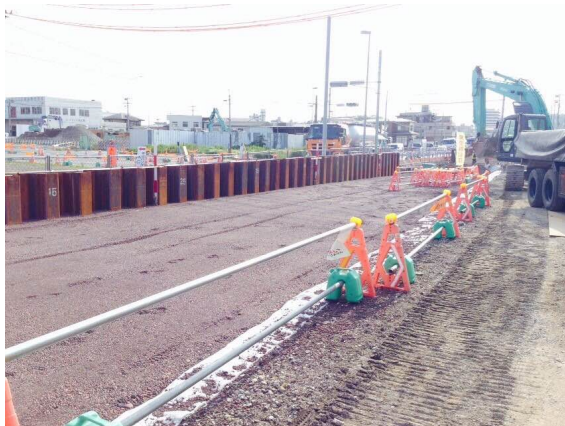
その1工事上下線道路施工開始(橋本店)
