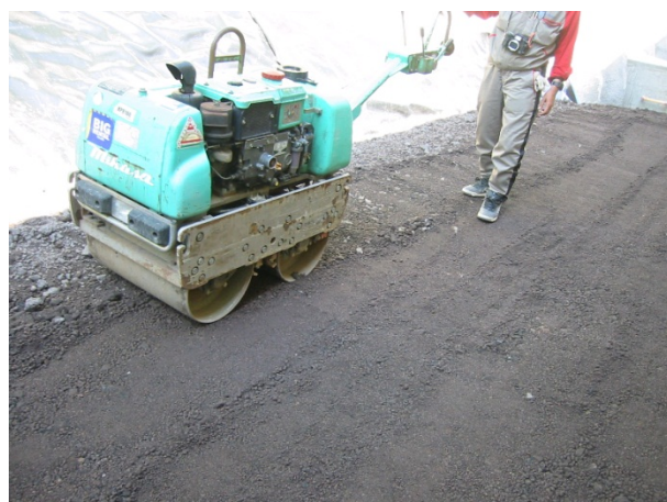
カルグリ施工状況(転圧)
