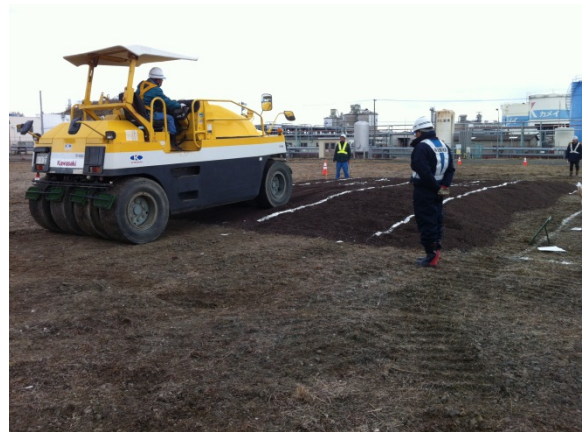
転圧使用機械(マカダムローラー、ロードローラによる締固め)
