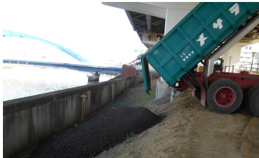
写真2 カルグリ荷卸し状況
