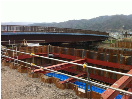
奥側(現橋:衣ヶ崎橋)手前側、新橋の基礎工事
