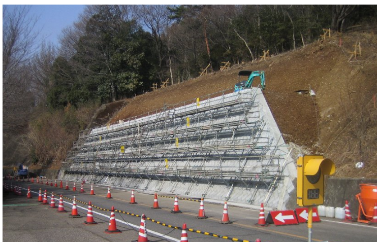
写真1 施工状況 ブロック積擁壁の裏込め材に カルグリを使用。 施工延長: 約45m 擁壁高さ: 約7m
