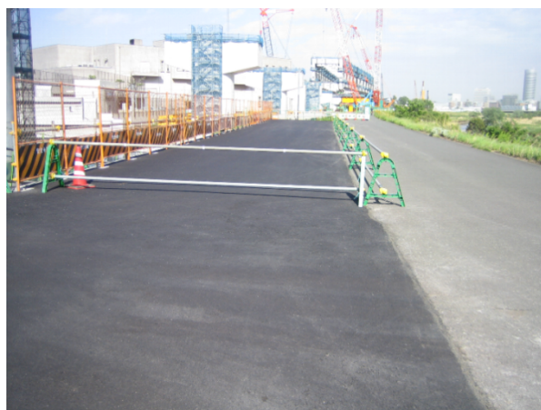
写真3 カルグリ施工後 アスファルト舗装の新しい部分がカルグリ施工部分 (古い舗装部分が既存堤防)。
