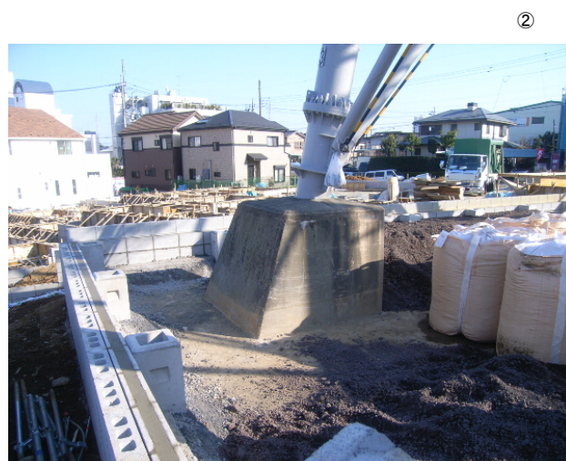
既存の上載土を除いた状態
