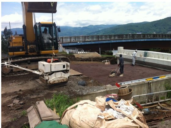
A2橋台 7層目敷均し締固め
