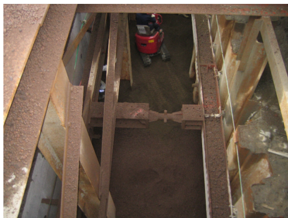
写真2 カルグリ施工箇所 写真左側が橋台コンクリート 施工箇所が狭小のため、小型重機を使用した。
