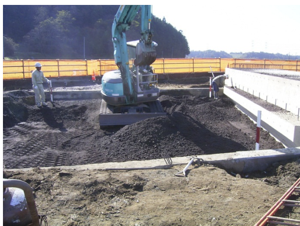
カルグリ施工状況
