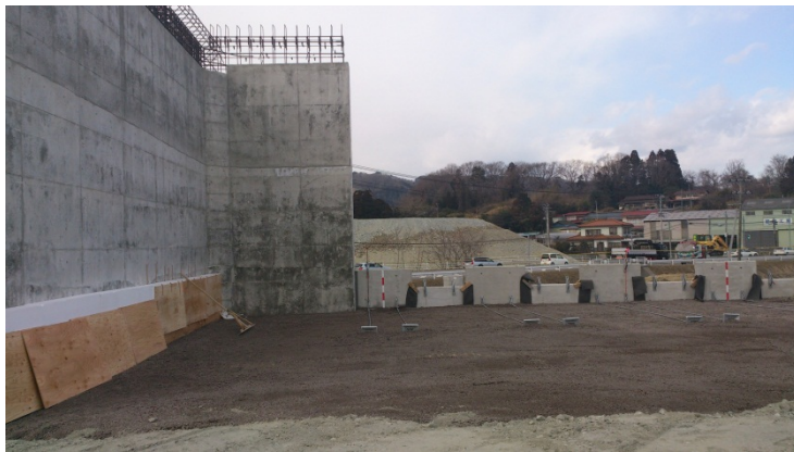
写真2 施工状況2 (橋台背面)
