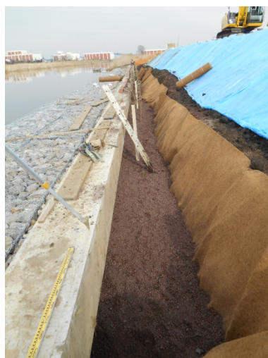
カルグリ施工状況
