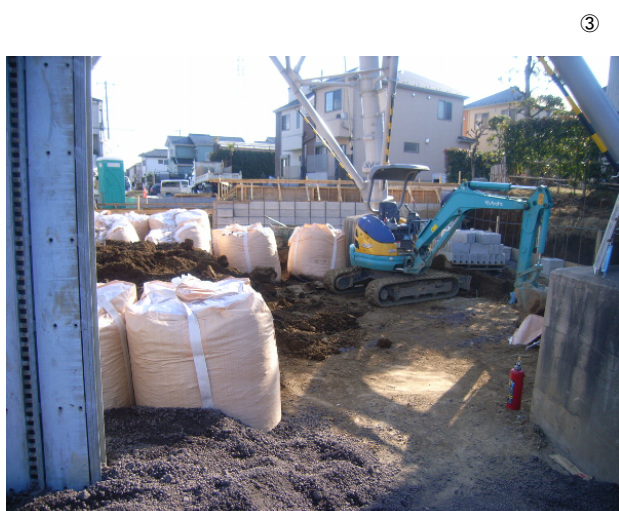
既存上載土除去中
