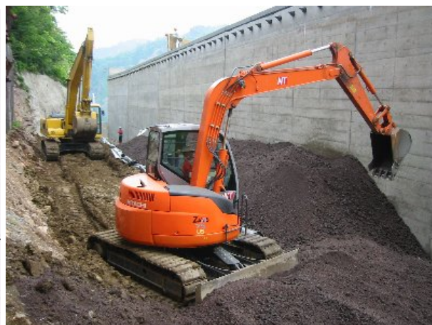
カルグリ施工状況
