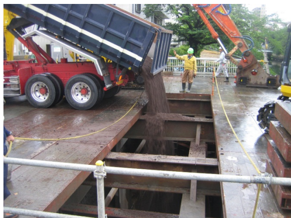
写真1 カルグリ投入状況 覆工板を外して、カルグリをダンプから直接投入
