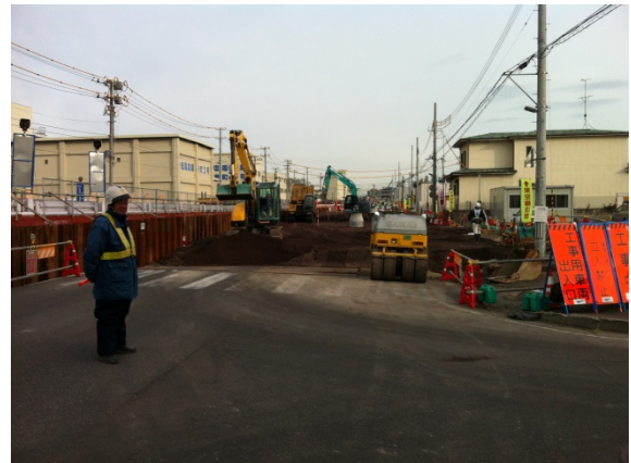
その2工事交差点施工開始
