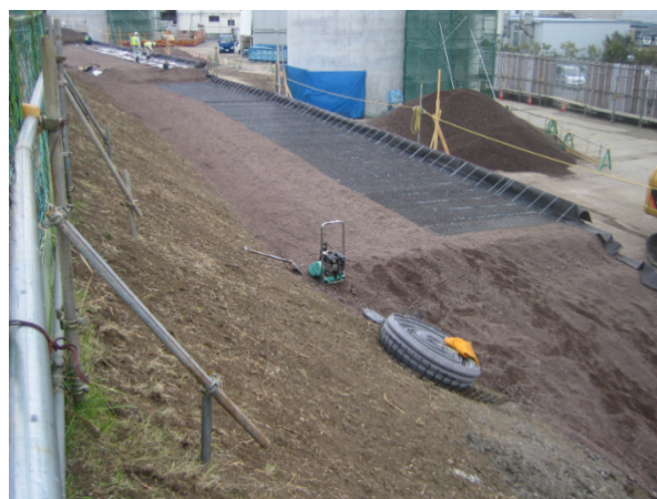
写真2 カルグリ施工状況
