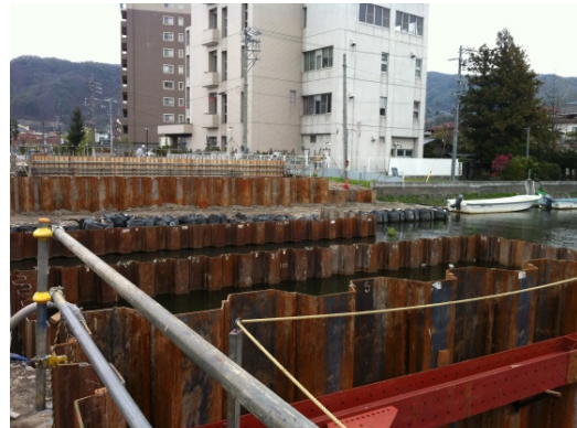
A1橋台基礎(奥側)、A2橋台基礎(手前)
