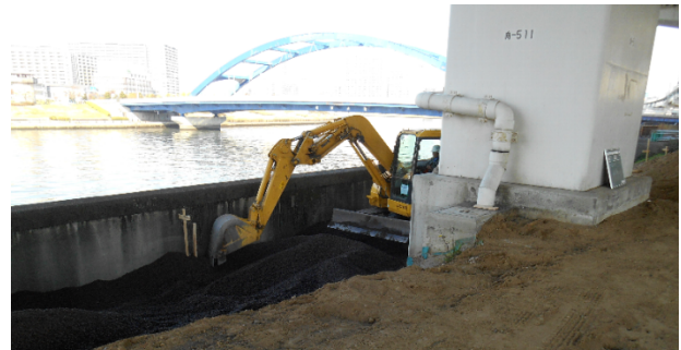
写真3 カルグリ施工(敷均し)状況
