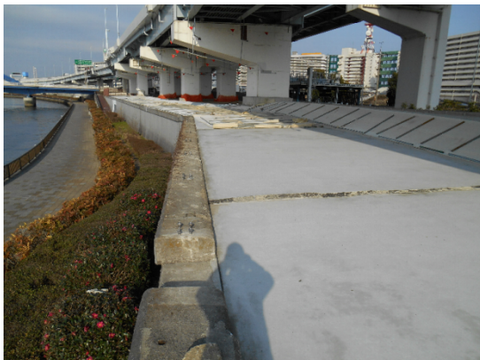
写真4 カルグリ施工後 カルグリ施工後はコンクリートを打設 写真左側が隅田川
