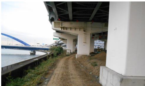
写真1 施工前 左側がコンクリート堤防 右側の橋脚は首都高の橋脚 コンクリート堤防背面がくぼんでいる。
