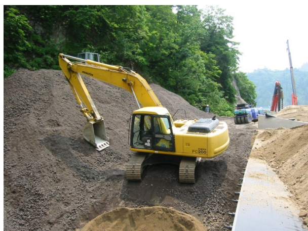
カルグリ施工状況(撒きだし)
