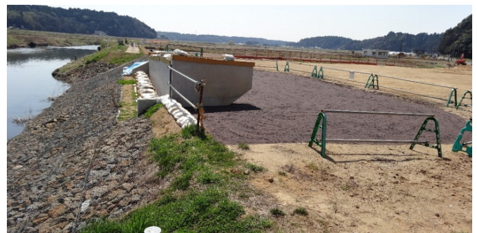
カルグリ施工完了
