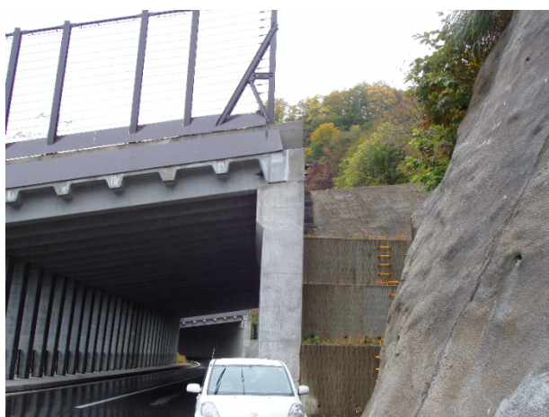
完成後（1年経過 2006年10月撮） 目視観察ではシェッド背面の裏込め部分には異常は見られない。
