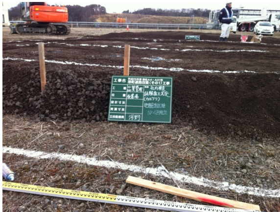
カルグリ試験施工(砂置換による密度試験)
