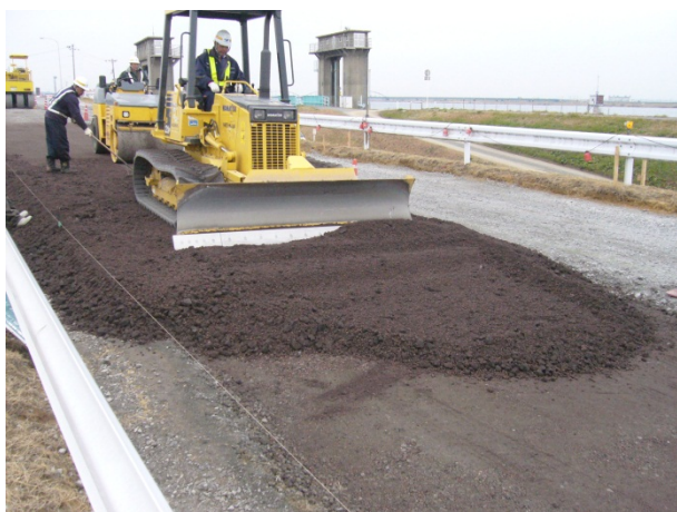
カルグリ敷均し状況
