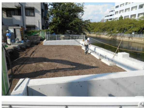
写真3 カルグリ施工完了後1 カルグリ施工完了後、カルグリ上面は普通土で被覆
