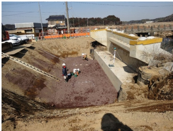
カルグリ施工開始(1層目締固め)
