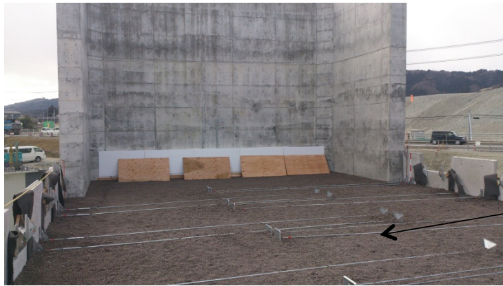
写真1 施工状況1 (橋台背面)
