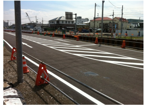
その①工事上り線施工完了
