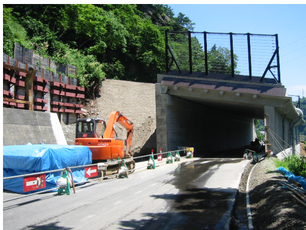
カルグリ施工後（埋戻し完了） カルグリ上部には覆砂された。
