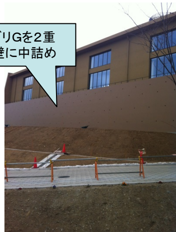
発生土で擁壁外部を盛土
