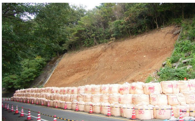
写真2 施工状況 仮復旧時
