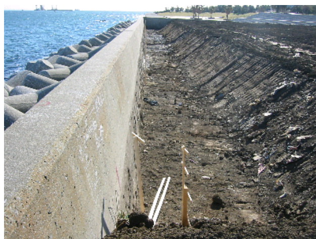
カルグリ施工前(掘削後)
