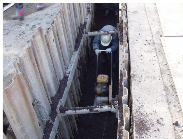
カルグリ締め固め状況
