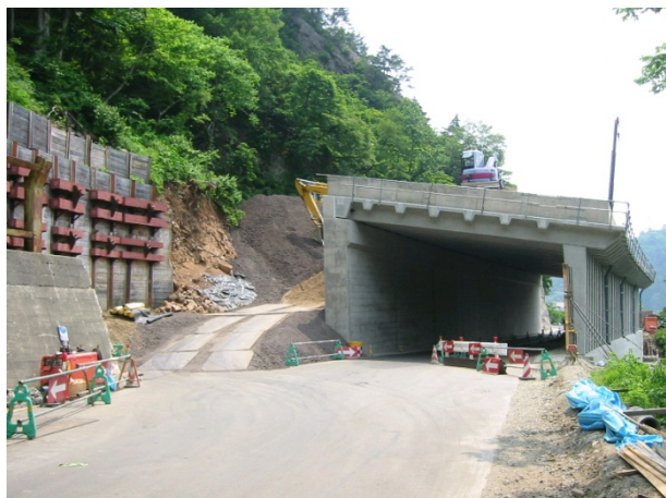
スノーシェッド全景
