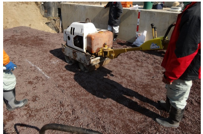
ランマ、プレートコンパクタ、小型振動ローラー
