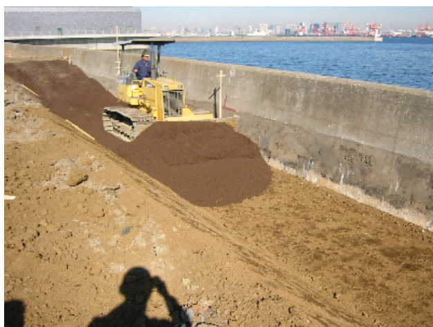
施工中(敷均し)
