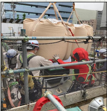
②ピット上、投入場所へ運びます。
