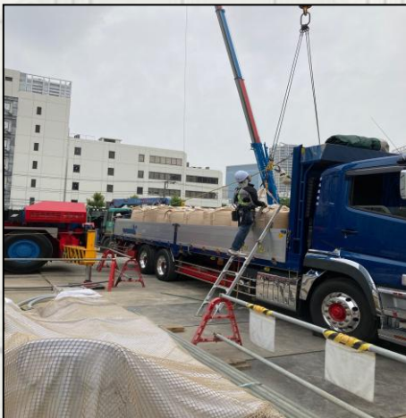
①クレーン等使用し、車上からフレコンを吊り上げます。
