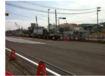
県道港町線嵩上げ工事 宮城県仙台土木事務所 震災復旧道路工事 施工数量 18,000m 3
