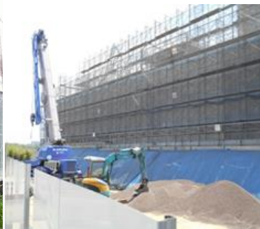
大学新校舎建設工事 都内某大学 校舎外郭 擁壁裏込め工事 カルグリG使用 施工数量 1,500m 3
