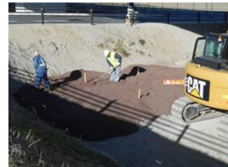
圏央道久喜幸手地区側道改良その3工事 国土交通省北首都国道事務所 圏央道下部工(護岸沈下防止) 施工数量1,600m 3 カルグリG使用
