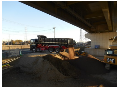
圏央道久喜幸手地区側道改良その3工事 国土交通省北首都国道事務所 圏央道下部工(護岸沈下防止) 施工数量1,600m 3 カルグリG使用
