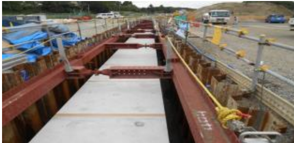
その4工事：ボックスカルバート埋設
