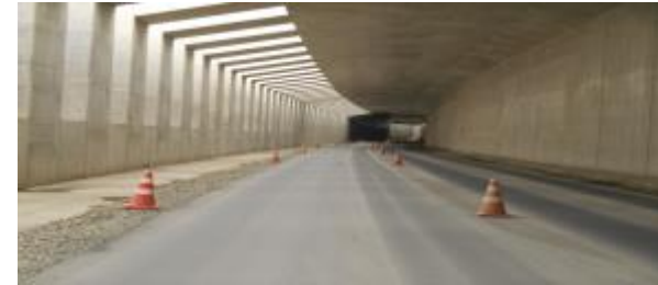
市川市堀之内地区半地下函渠：施工中
