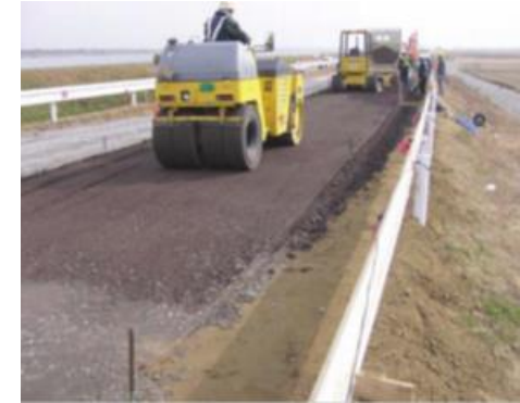
③コンバインドローラーによる転圧
