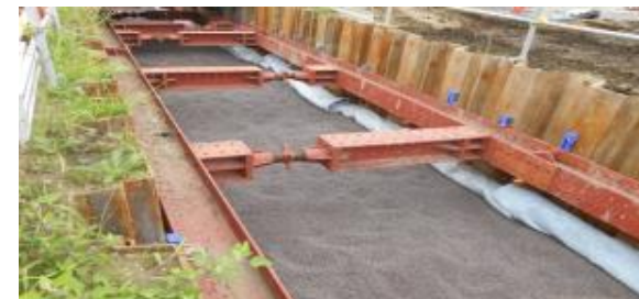
カルグリG敷き均し
