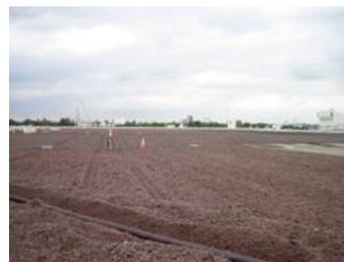
下水終末処理場覆蓋緑化工事 埼玉県 荒川左岸終末処理場上部利用 基盤整備工事 施工数量 8,000m 3
