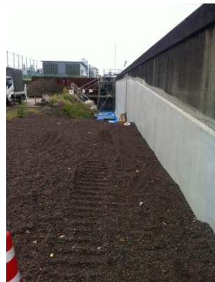
隅田川(西尾久三丁目地区)築堤工事 東京都建設局江東治水事務所 隅田川高潮防御施設整備事業 施工数量:520m 3 カルグリ使用
