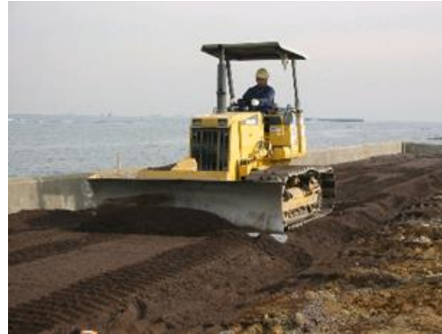
②ブルによる撒き出し
