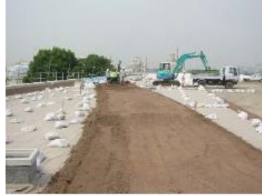
下水終末処理場覆蓋緑化工事 埼玉県 中川下水道事務所上部利用 基盤整備工事 施工数量 1,400m 3
