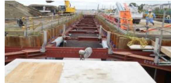
カルバート底面にもカルグリ充填(一部工区)
