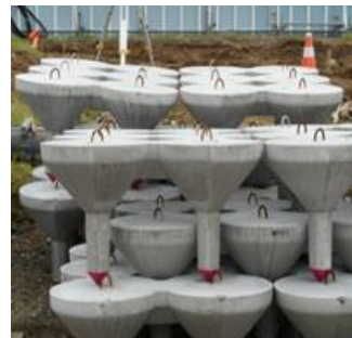
浄水場内正門整備工事 北千葉広域水道企業団 沈下対策 カルグリG使用 施工数量 100m 3
