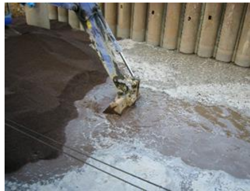
②バケット先端で均し
