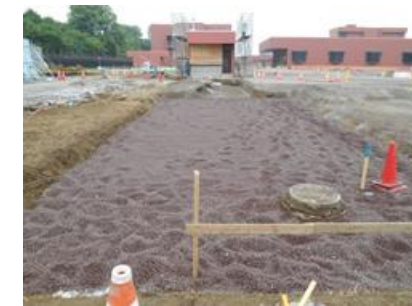
浄水場内正門整備工事 北千葉広域水道企業団 沈下対策 カルグリG使用 施工数量 100m 3
