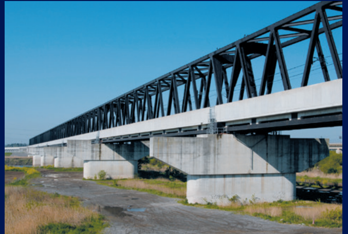
つくばエクスプレス・利根川橋梁（日本鉄道建設公団）
