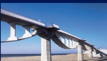
浜松御前崎自転車道 潮騒橋
