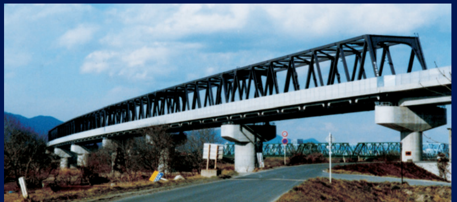
北陸新幹線、第三千曲川橋梁（日本鉄道建設公団）
