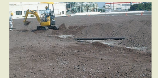
▲下水処理場覆蓋緑化工事で施工された排水材。カルグリを排水材として使用しています。
