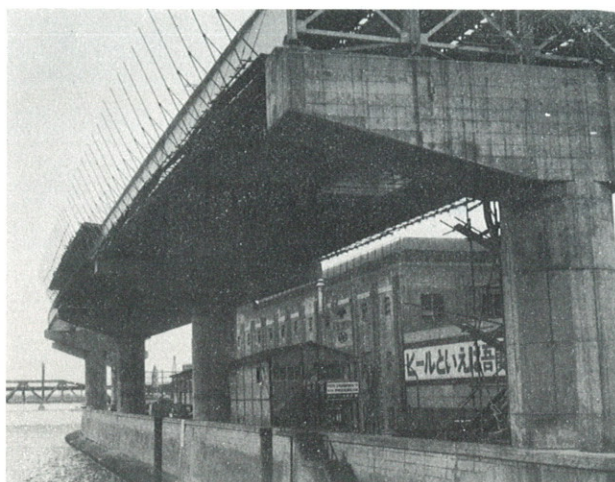
(1)首都高速道路6号線(鉄骨軽量コンクリート床版)
