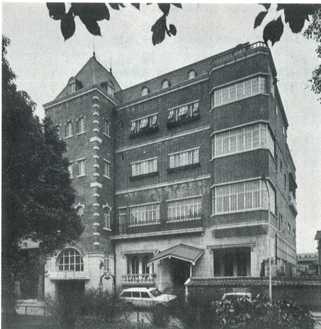
クレセントビル 〈地上4階〉
