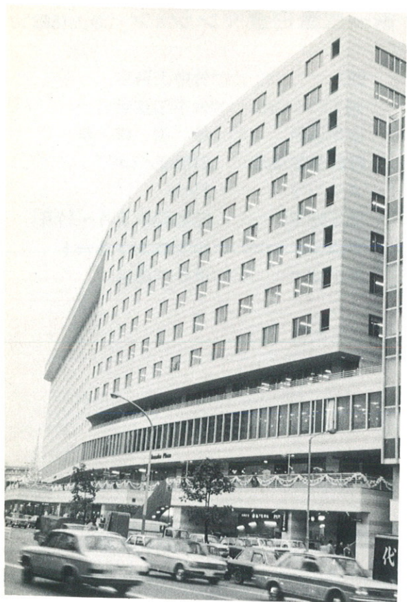
赤坂東急プラザ〈地上14階〉
