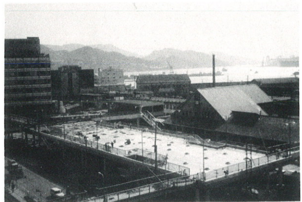
高架広場全景 (22×76≒1672m 2 )
