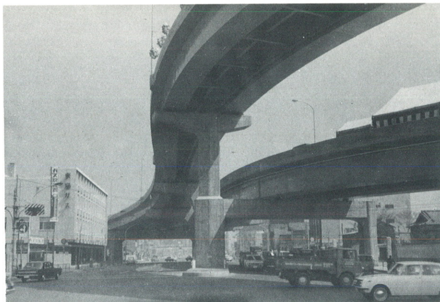
首都高速道路 5 号線 (R.C.床版)
