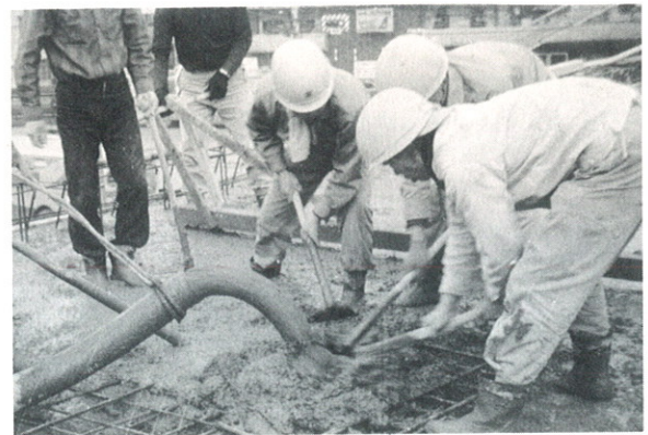
ポンプによるメサライトコンクリートの打設状況
