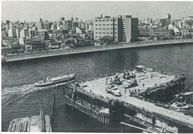
写真3 軽量コンクリートを河底フーチングに打設している現場（首都高速道路公団東両国インターチェンジ）
