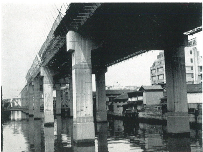
首都高速道路公団7号線（高架橋床版）
