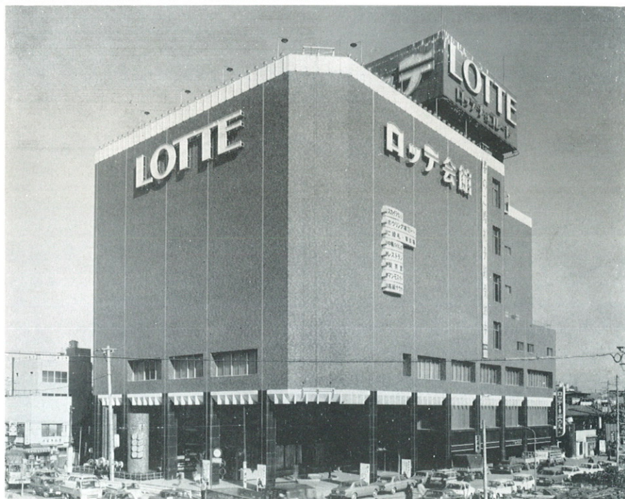
ロ ッ テ 会 館 〈地上10階〉
