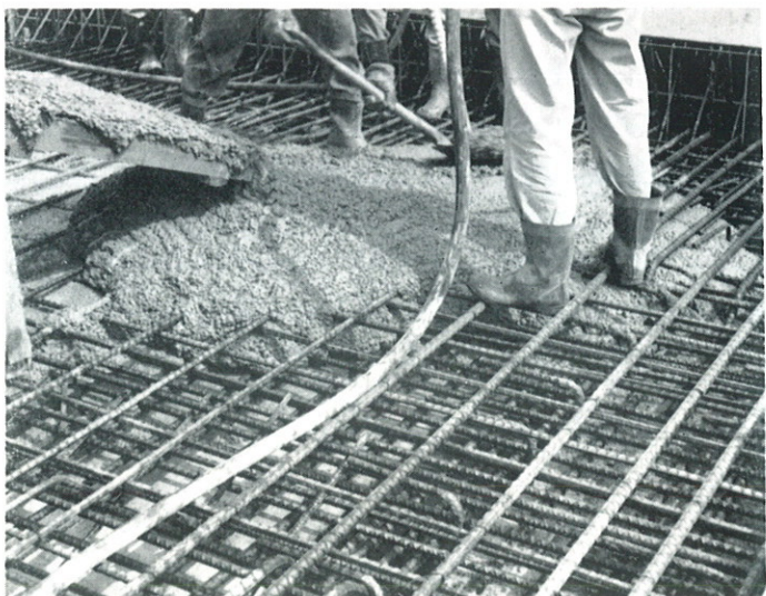
首都高速道路公団3号線（高架橋床版）
