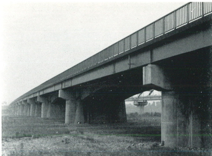
多摩川原橋（歩道床版）
