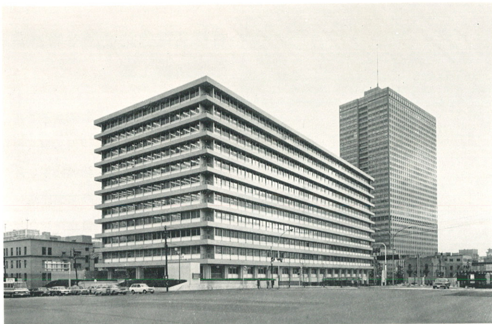
中央合同庁舎四号館<地上12階>
