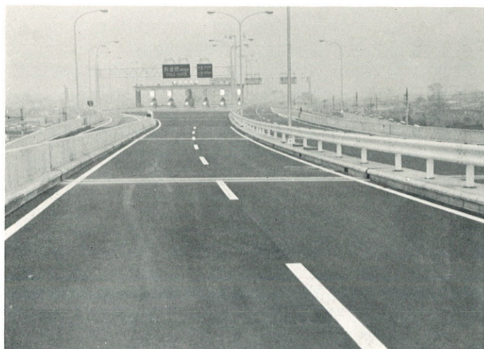
首都高速道路公団 3 号線高架橋 床版新設工事
