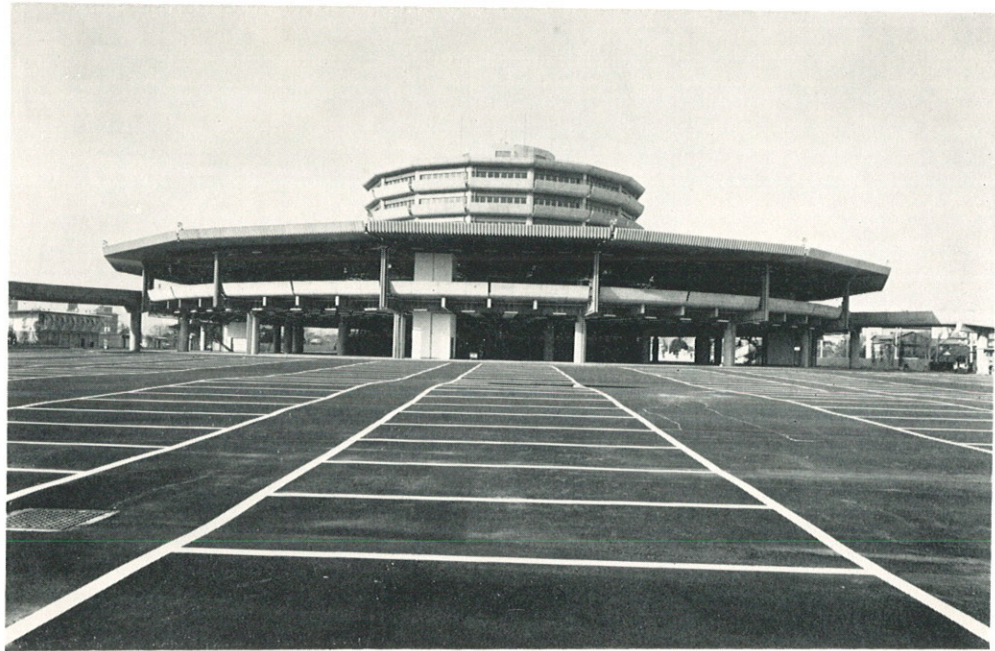
中央卸売市場世田谷市場<地上6階>
